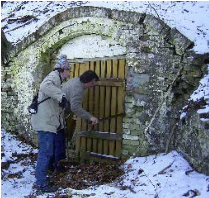
Kontrolle eines Winterquartiers in einem alten Bierkeller
